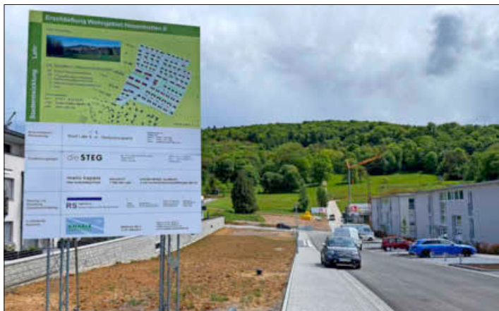
Auf dieser Fläche östlich der neuen Brücke entsteht der Quartiersplatz.
