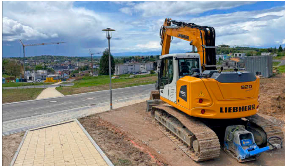
Die Straßen sind fertig, die Häuser werden bald folgen.
