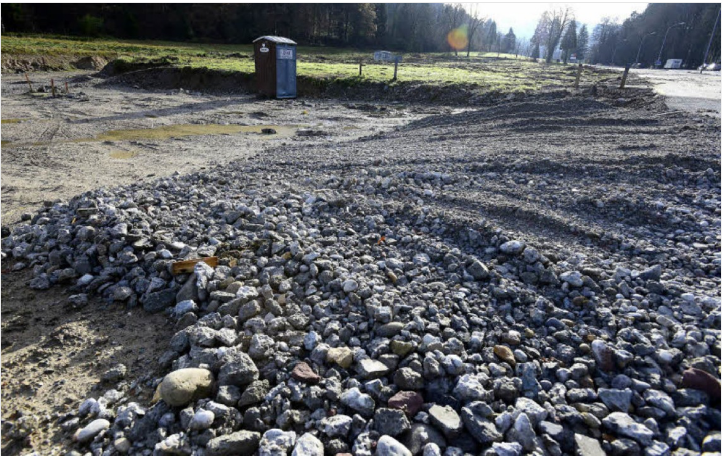
Die Erschließungsarbeiten im Günterstaler Baugebiet haben bereits begonnen. Foto: Ingo Schneider
